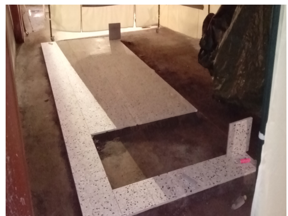
Figur 5: Exempel på lagda plattor med maskinen. Vi la 10-20m 2 yta vid varje fälttest. Plattorna bröts upp efteråt och fästytan mellan plattor och bruk analyserades.
