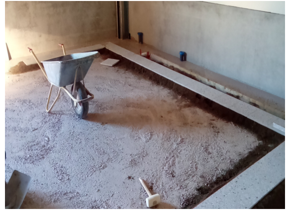
Figur 4: En ram med plattor (s.k. fris) läggs manuellt runt området som ska läggas. Den tjänar som referens för att få rätt höjd och raka rader. En sådan fris används även av dagens plattläggare. Frisen som användes i testerna gjordes också av erfarna plattläggare. Även det bruk och slam som användes blandades och lades ut av plattläggare. Normalt är frisen bredare än de som användes i testerna men principen är densamma.
