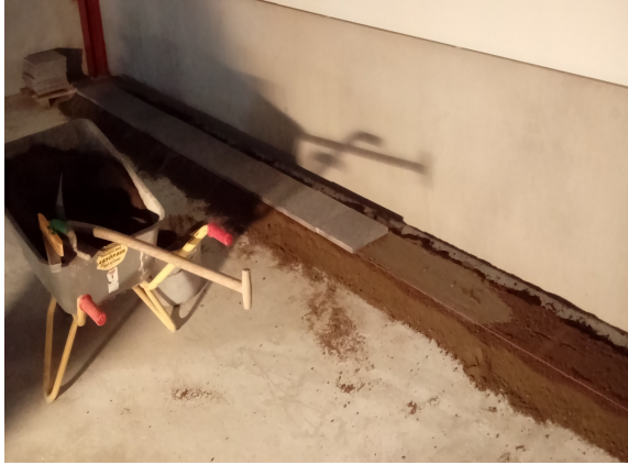
Figur 4: En ram med plattor (s.k. fris) läggs manuellt runt området som ska läggas. Den tjänar som referens för att få rätt höjd och raka rader. En sådan fris används även av dagens plattläggare. Frisen som användes i testerna gjordes också av erfarna plattläggare. Även det bruk och slam som användes blandades och lades ut av plattläggare. Normalt är frisen bredare än de som användes i testerna men principen är densamma.
